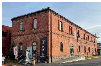
旧本庄商業銀行煉瓦倉庫
