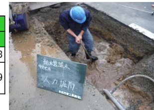
【配水管漏水の復旧工事】
