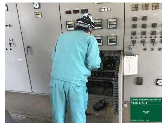
計装設備点検業務の状況
