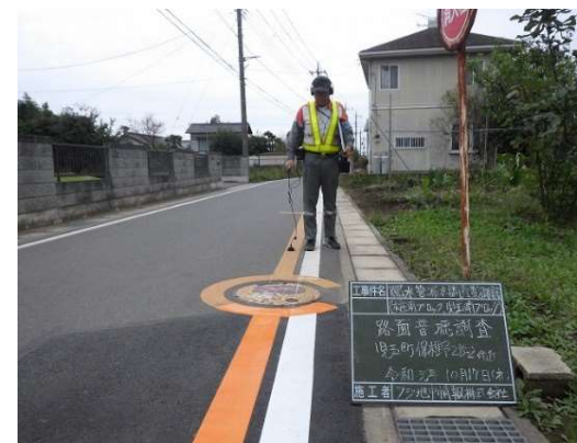
給配水管漏水調査業務の状況
