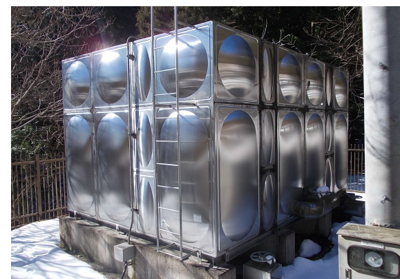
平沢配水場 配水池
