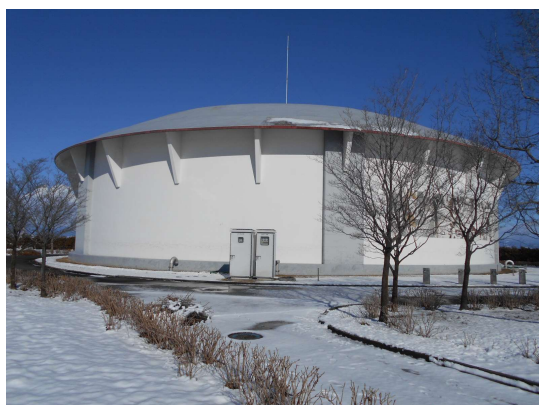
第二浄水場 第3配水池
