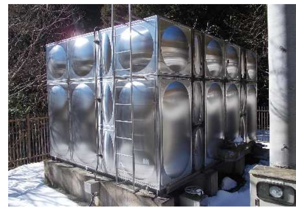
平沢配水場 配水池
