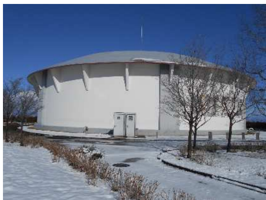
第二浄水場 第3配水池
