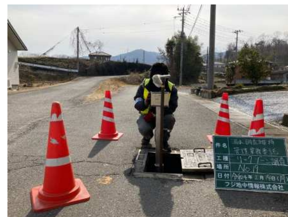
給配水管漏水調査業務の状況
