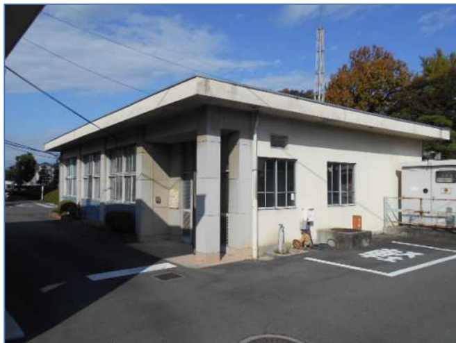
第一浄水場 第1ポンプ室
