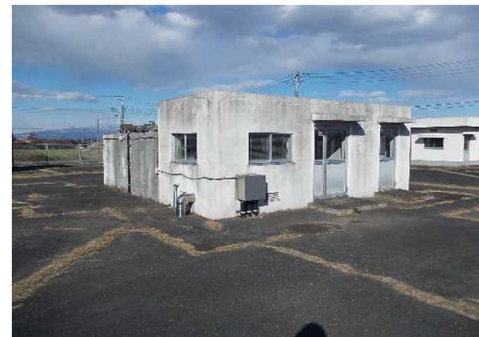
金屋送水ポンプ場 ポンプ井 15
