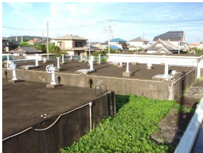
児玉浄水場 浄水池
