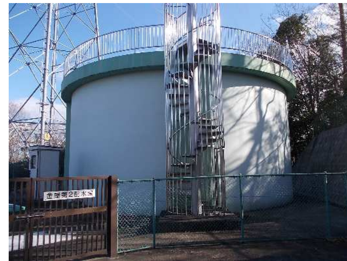
金屋第二配水場
