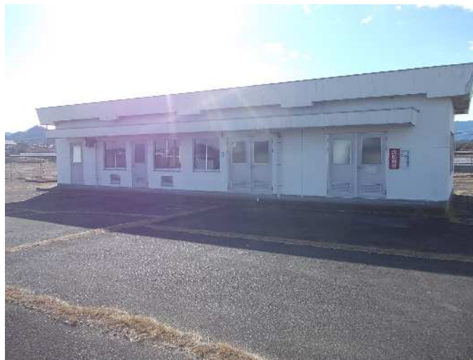
金屋送水ポンプ場
