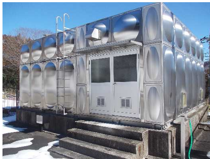
太駄上配水場
