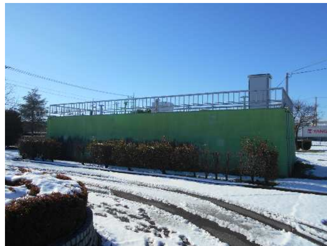
第二浄水場 第2着水井
