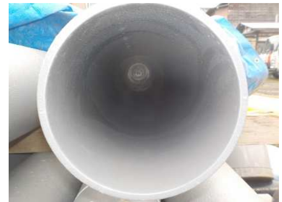
更新工事で使用している新しい管の内部
