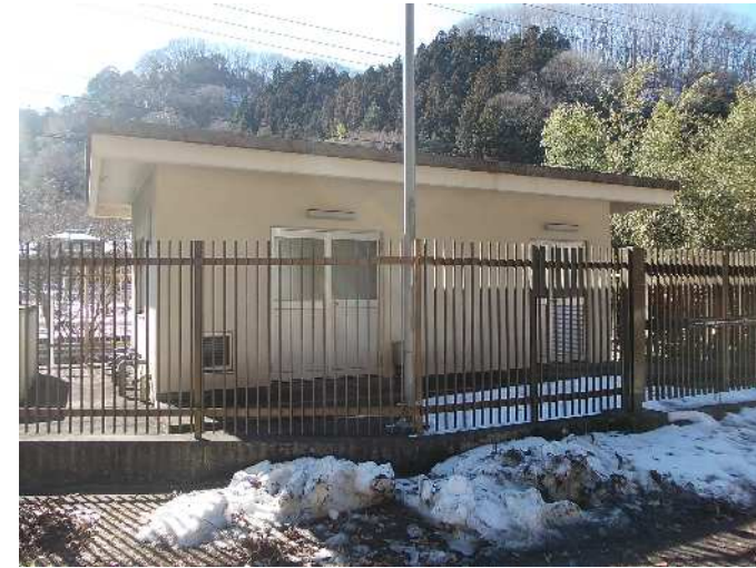
河内送水ポンプ場
