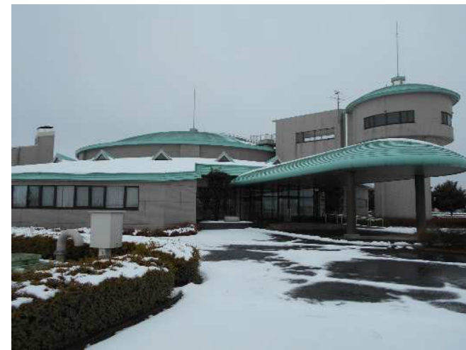
都島浄水場 配水池・着水井
