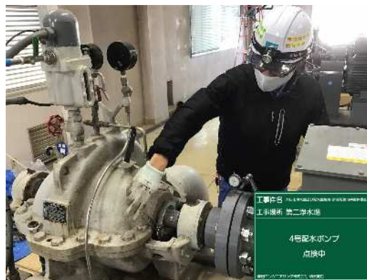
機械設備の点検状況(配水ポンプ)
