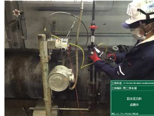
電気設備の点検状況(圧力計)
