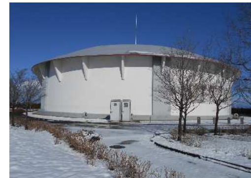
【耐震化工事を必要とする第二浄水場第3配水池】
