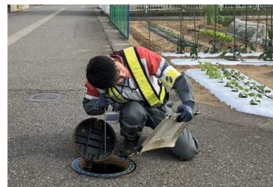
給配水管漏水調査業務の状況
