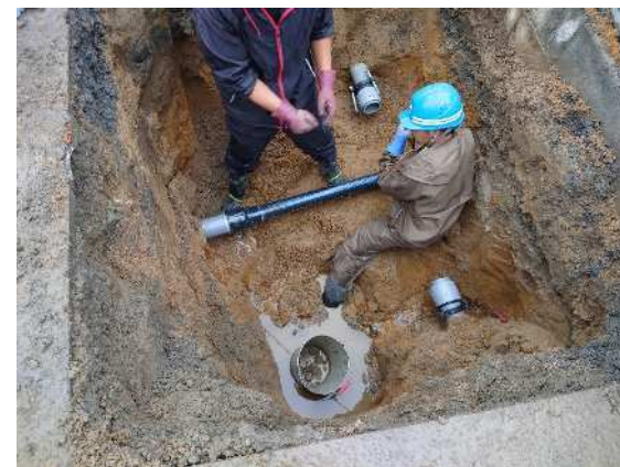
漏水修繕の状況
