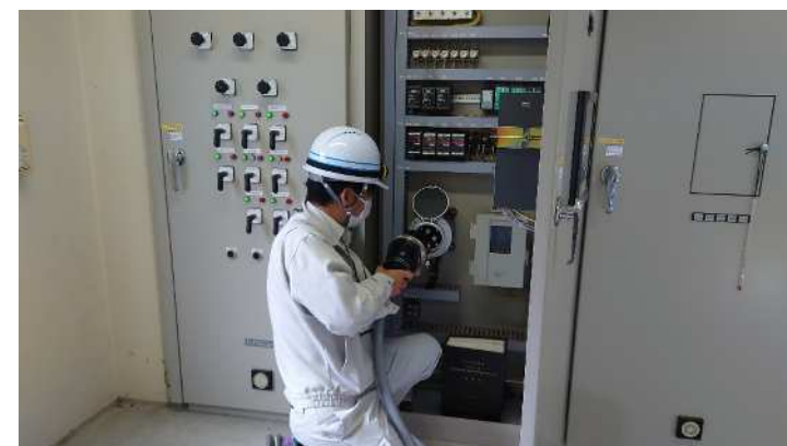
送水ポンプ場の非常電源の接続訓練状況
