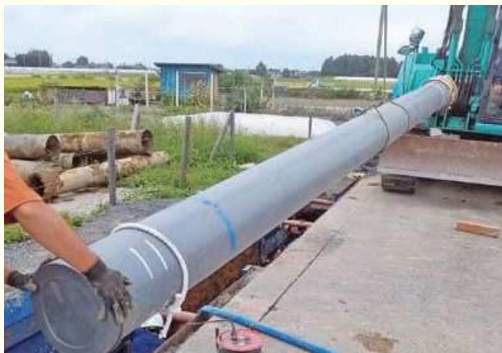
▲ 水道管の更新工事
