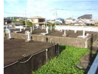
児玉浄水場 浄水池
