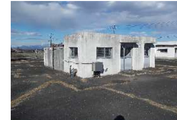
金屋送水ポンプ場 ポンプ井
