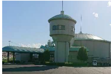
都島浄水場 配水池・着水井
