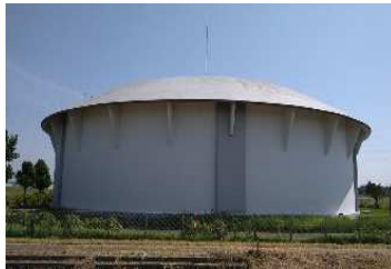
第二浄水場 第3配水池
