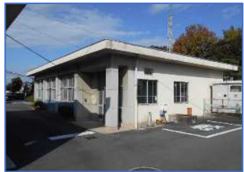
第一浄水場 第1ポンプ室
