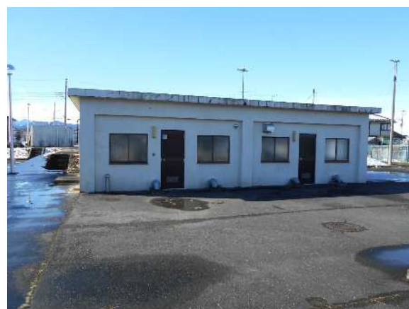
送水ポンプ室
