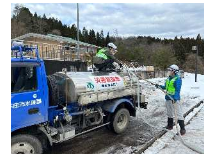
⑨活動場所から10kmほど離れた輪島市地原浄水場で、給水車へ補水の状況
