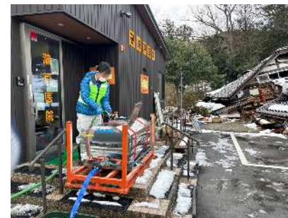
⑧瀬戸医院で給水の状況
