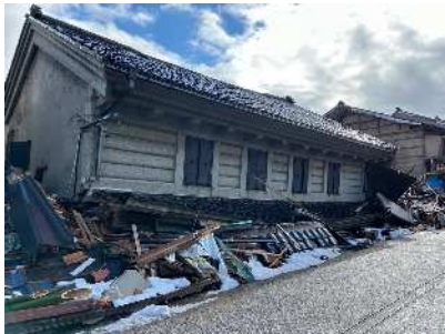
1階部分が押し潰され倒壊した家屋
