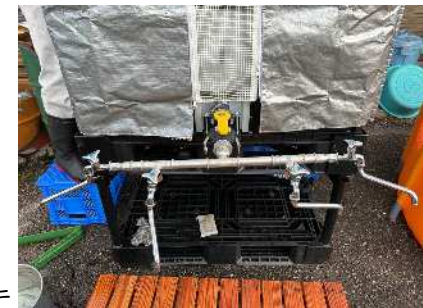
⑩仮設水槽の蛇口の状況
