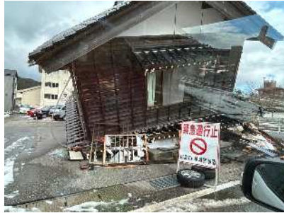
1階部分が押し潰され倒壊した家屋
