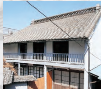
諸井家住宅 諸井泉衛が横浜の洋館を手本に建築。当初は本庄郵便局と居宅を兼ねていた。埼玉県指定文化財だが、現在は原則非公開となっている。
