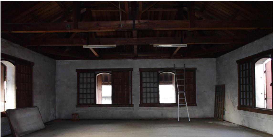
図 3-47. すべての開口部に同じ機構の建具が取り付け
