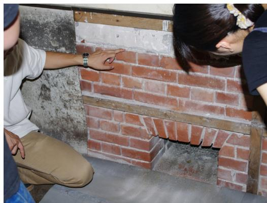
図 3-45. 解体実測調査によって確認された開口部下の通気口
