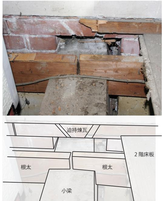
図3-26. 小梁と煉瓦壁 取り合い部分写真
