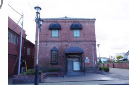
旧中山道側からみる煉瓦倉庫
