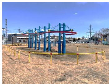
若泉運動公園：寄贈された遊具等の設置
