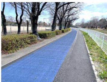
若泉運動公園：ランニングコース舗装（令和6年度整備）
