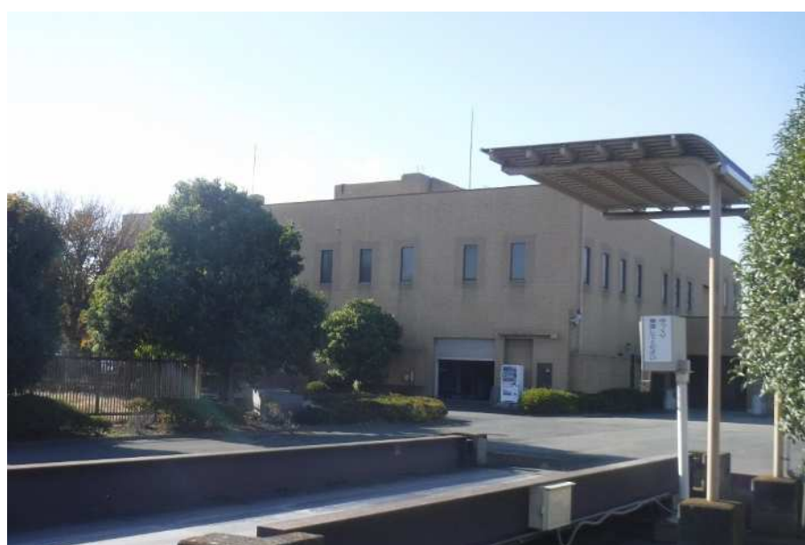
利根グリーンセンター外観
