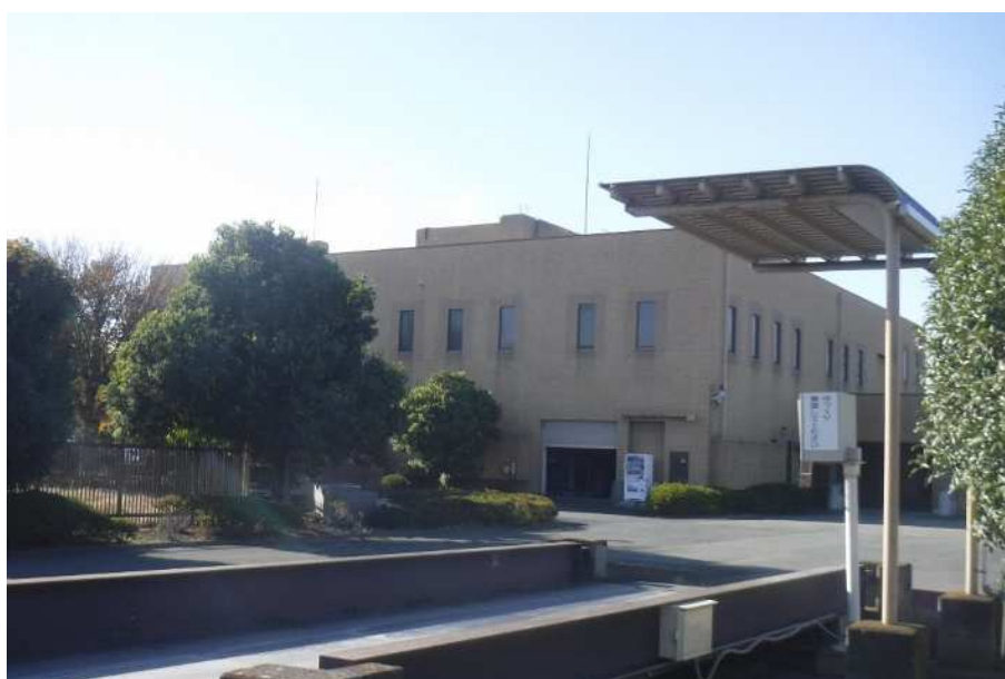
利根グリーンセンター外観
