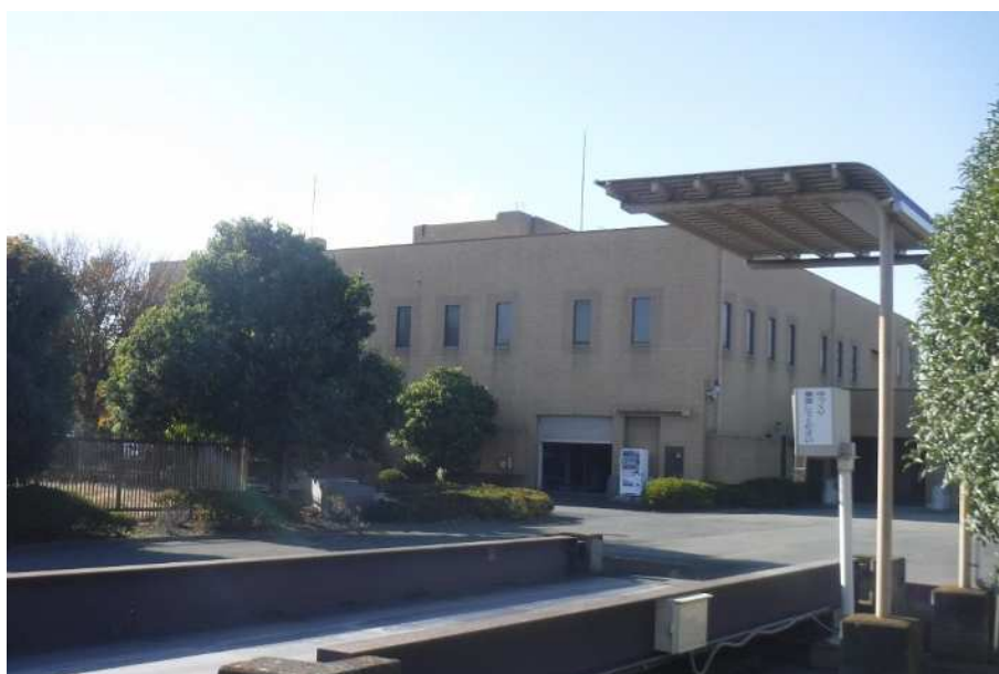
利根グリーンセンター外観
