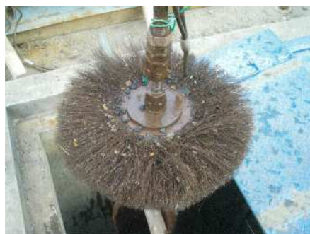
揚水試験による井戸能力の確認
