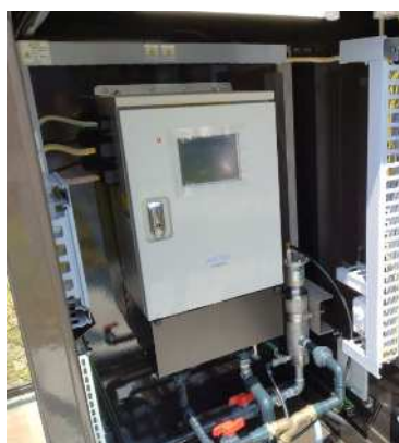
既設水質自動計測装置
