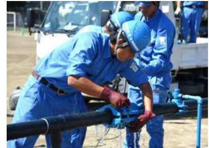
水道復旧訓練
