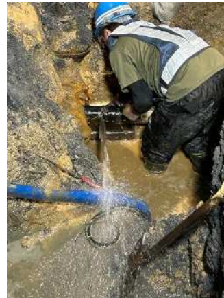
漏水箇所の修繕
