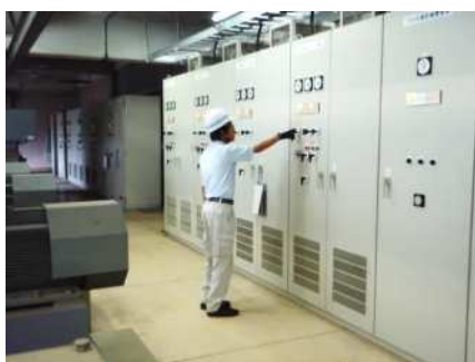
電気設備の点検
