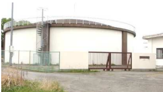
太駄上配水場・平沢送水ポンプ場
