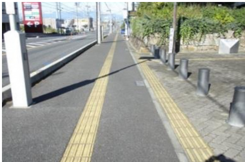
▲市役所前の視覚障害者誘導用ブロック(1)
