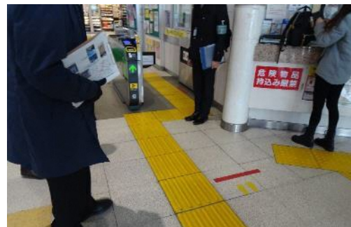
▲改札前の視覚障害者誘導用ブロック(40)
