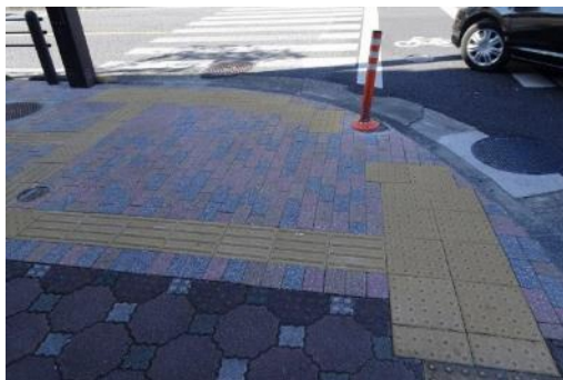
▲交差点部の歩道での傾斜(28)
