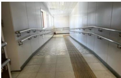
▲北口エレベーターに至るスロープ(43)
