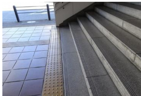
▲コントラストのない段鼻部(47) 1列の視覚障害者誘導用ブロック(48)
