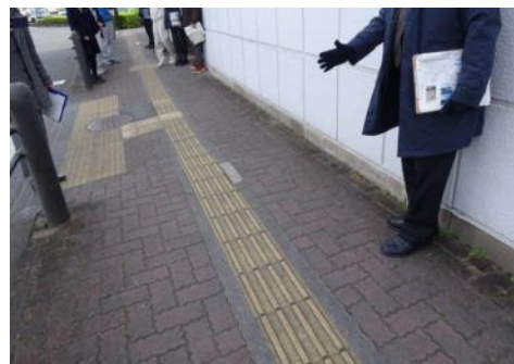
▲北口のエレベーター前の歩道(53)
