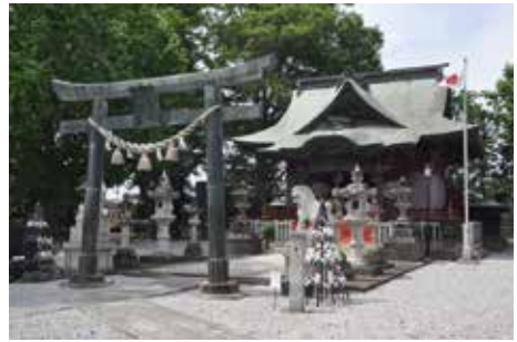
写真 2-3 八幡神社社殿及び銅製鳥居
