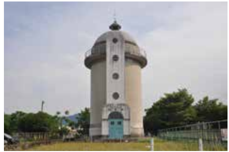
写真 2-13 児玉町旧配水塔
