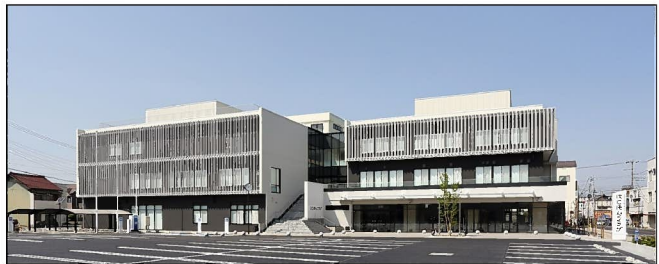
はにぼんプラザ (H27竣工)
