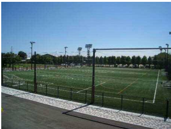
△若泉運動公園多目的グラウンド（人工芝グラウンド）
