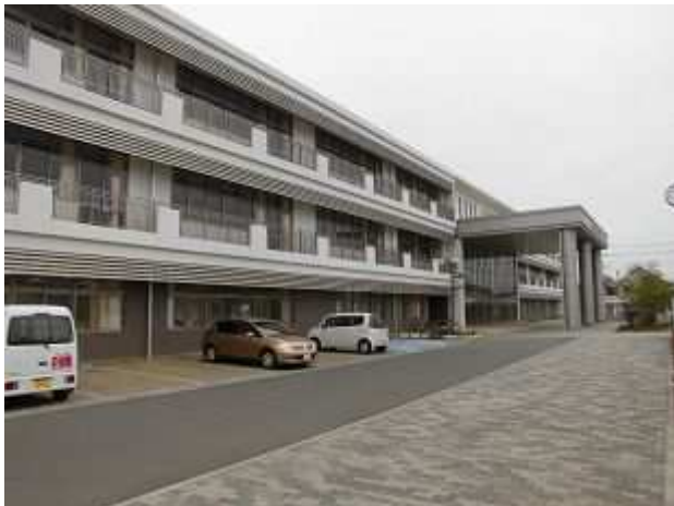
東中学校校舎(平成27年度竣工)
