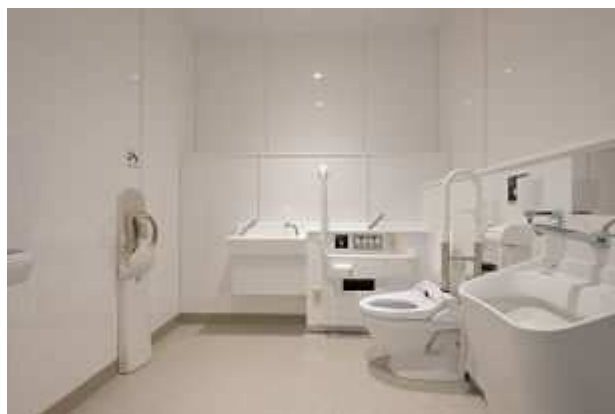
新たに設置した多機能トイレ
