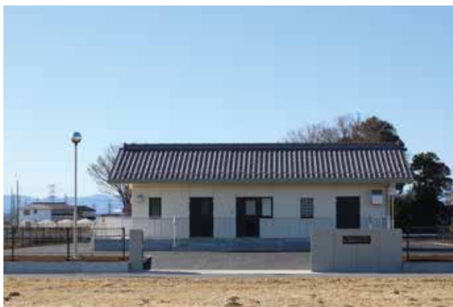
農業集落排水事業の施設 (仁手・下仁手・久々宇クリーンセンター)
