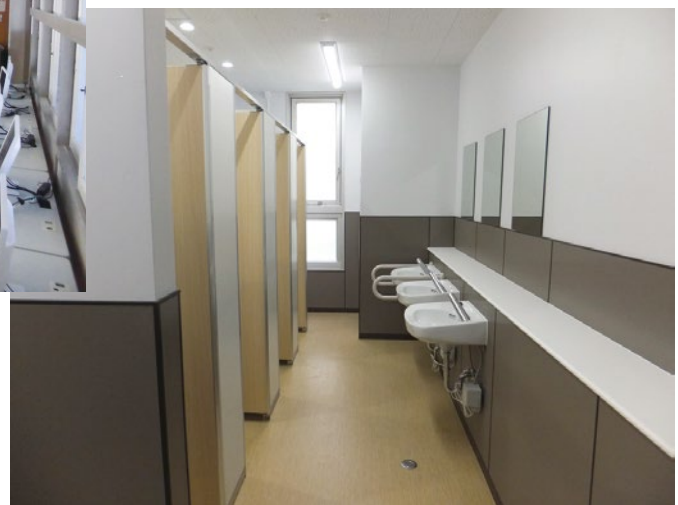
改修後のトイレ
