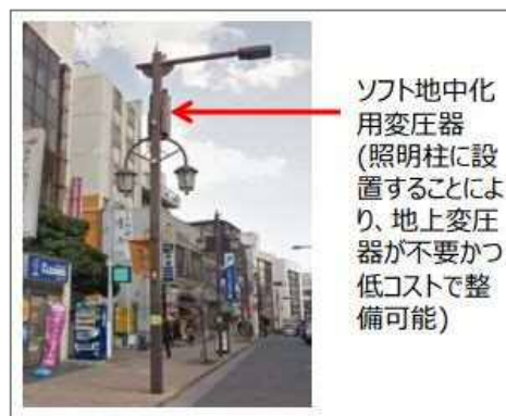
図 4-6 ソフト地中化方式のイメージ
