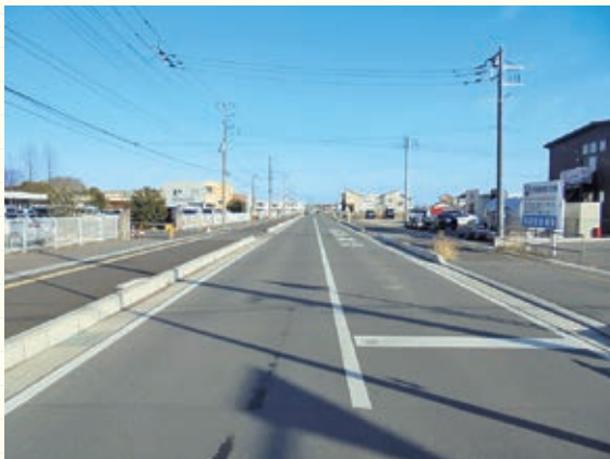
▲ 道路改良「新田原通り線」
