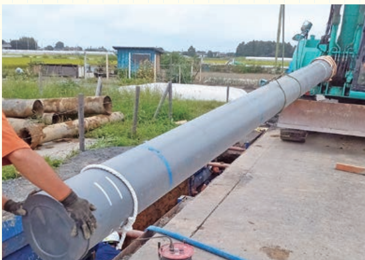
▲ 水道管の更新工事
