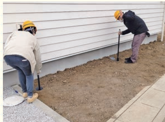
▲ 公共下水道等の水洗化(接続)に伴う排水設備検査
