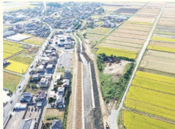
▲ 河川改修「女堀川」
