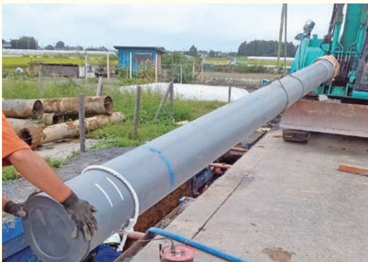
▲ 水道管の更新工事
