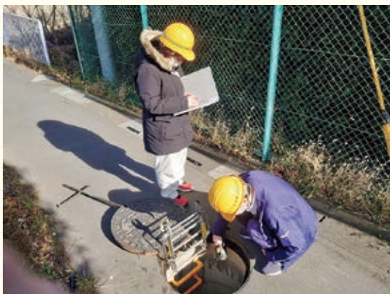
▲ 公共下水道等の維持管理のためのマンホール点検
