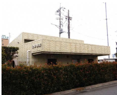
老朽化した公衆トイレ
