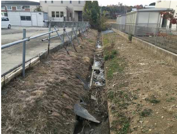
排水路の改修、暗渠にして道路化 (平成28年度 自治会要望)
