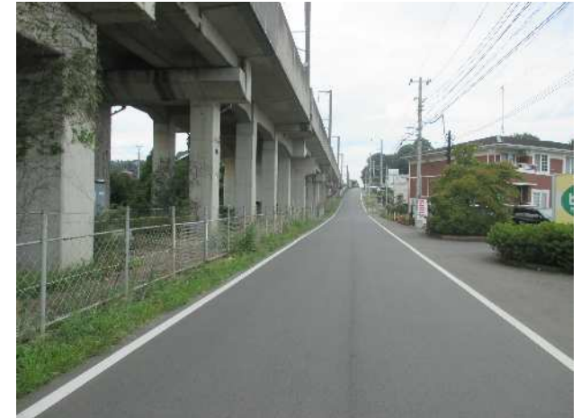
市道8498号線等の舗装修繕 (平成29年度 ワークショップ)
