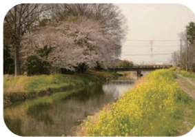
備前渠用水路（備前堀）
