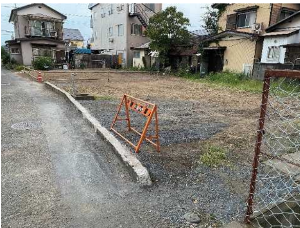
南西側から見た解体後の敷地
