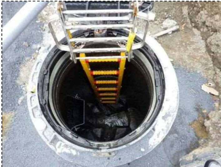
参考・硫化水素に強い部材で改修工事を実施
