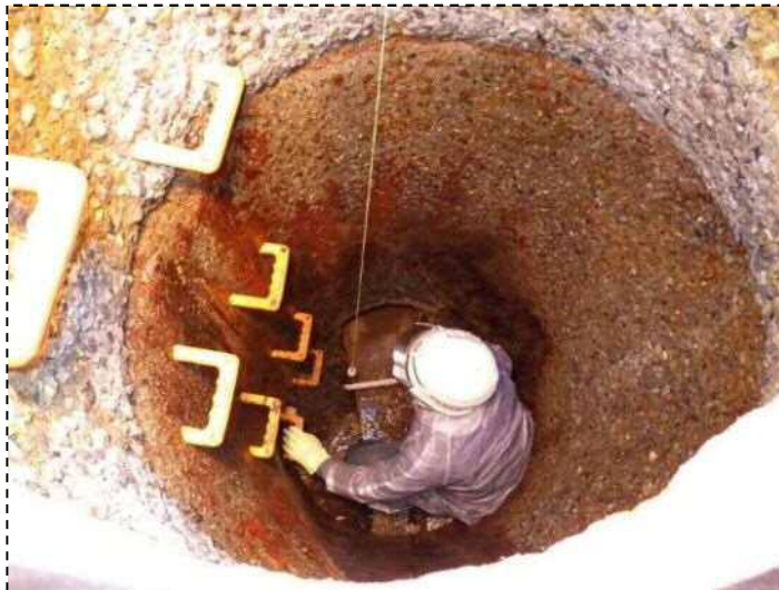
参考・硫化水素に強い部材で改修工事を実施
