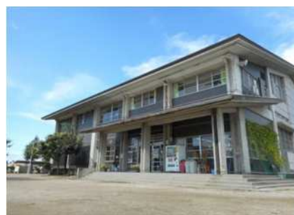
若泉運動公園武道館
