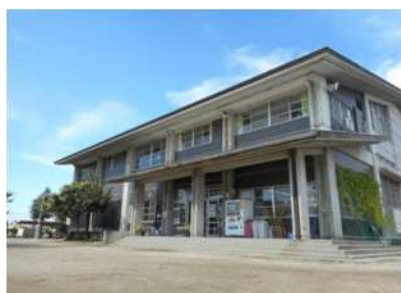
若泉運動公園武道館
