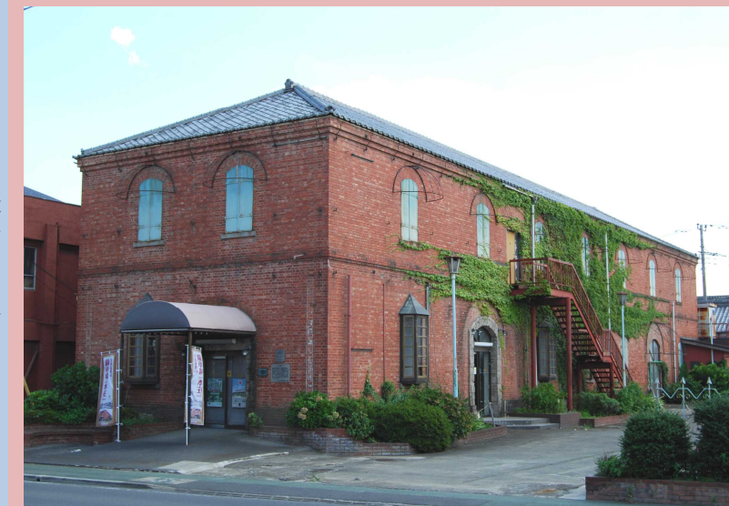
旧本庄商業銀行煉瓦倉庫（明治29年建設）
