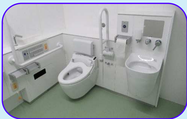
本庄南小学校 多目的トイレ
