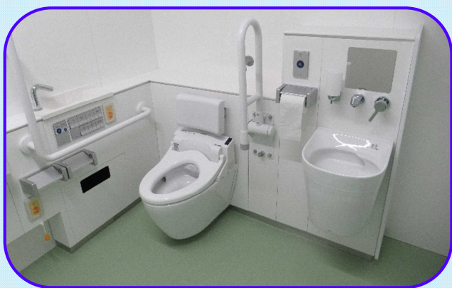
本庄南小学校 多目的トイレ
