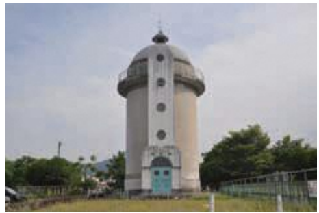
写真 2-13 児玉町旧配水塔
