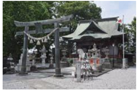
写真 2-3 八幡神社社殿及び銅製鳥居
