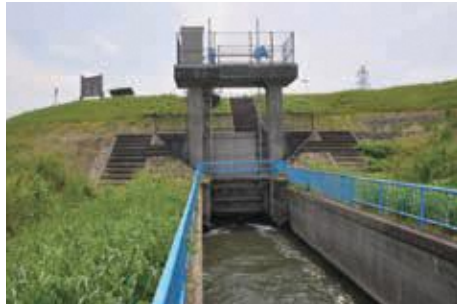
写真 9-6 備前渠用水路（第3樋門）
