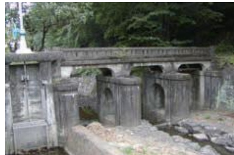
写真 9-9 間瀬堰堤管理橋
