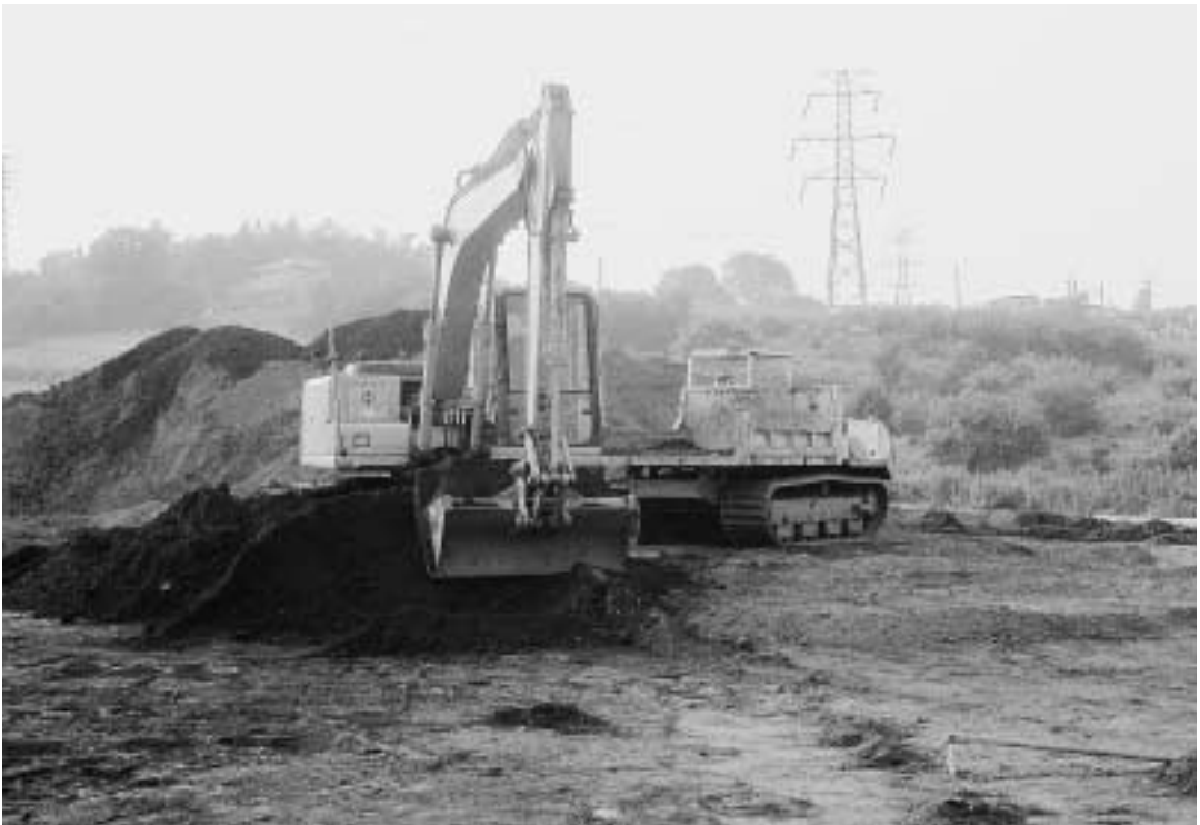
2. B地点調査1区 表土掘削
