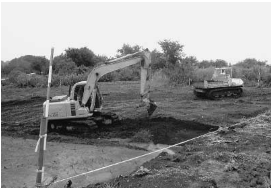
2. B地点調査2区 表土掘削
