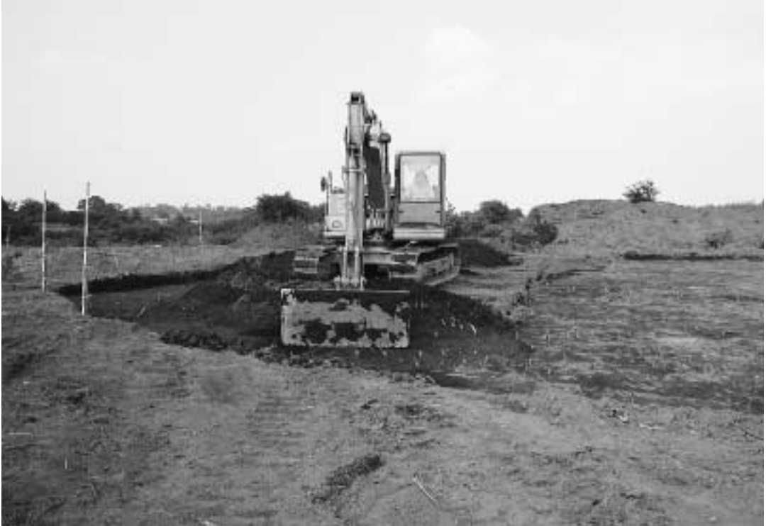
1. B地点調査1区 表土掘削
