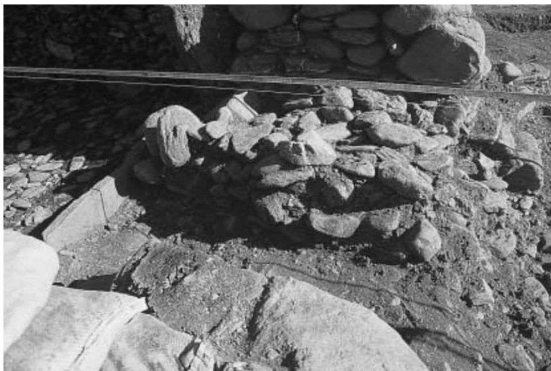
閉塞部断ち割り状況（南東から）
