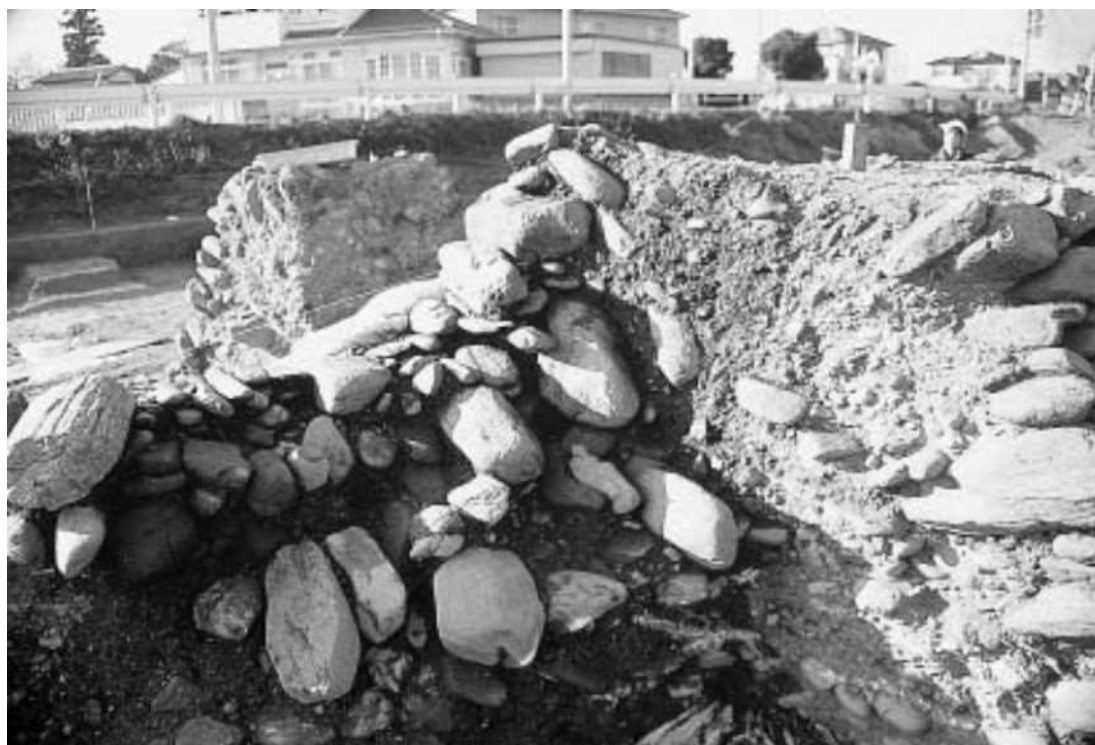
東側壁裏側の状況 2（南東から）
