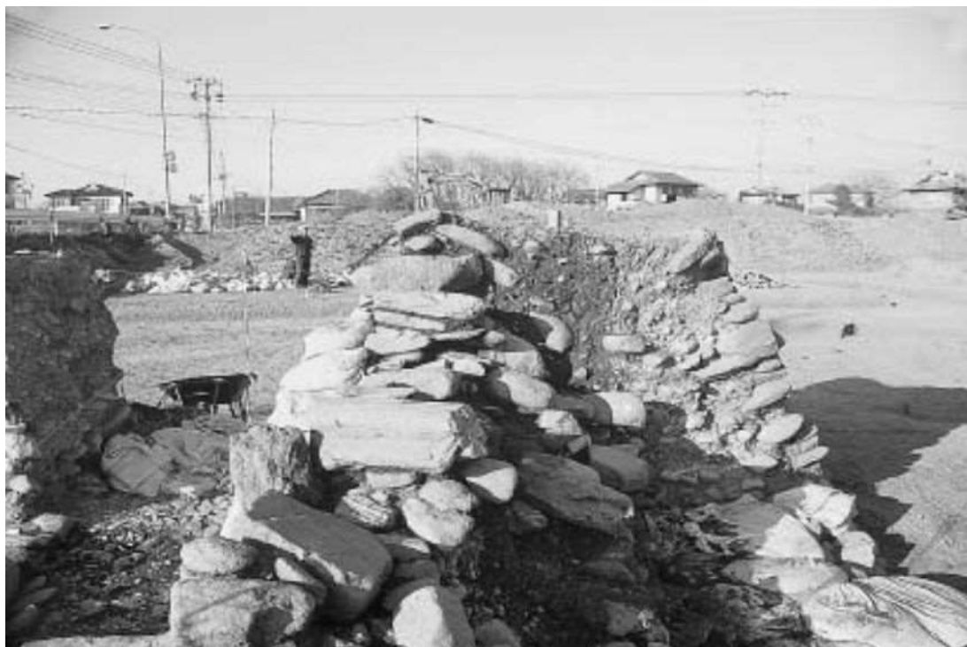
東側壁裏側の状況 1（南から）
