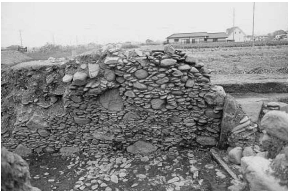
東側壁（部分 1・南側、西から）
