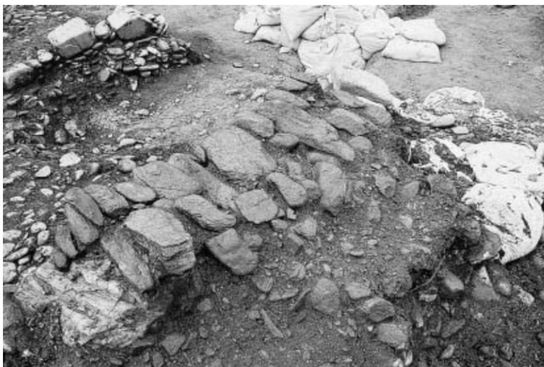
東側壁裏側の状況 4（南東から）
