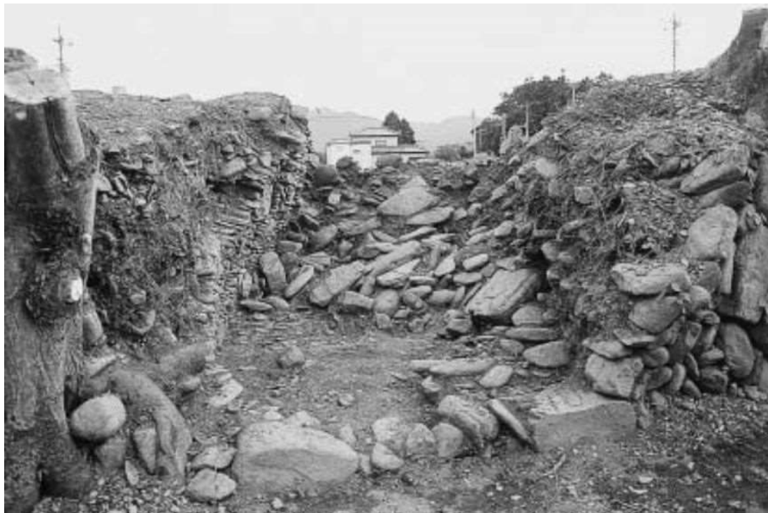
西側壁崩落状況（北から）
