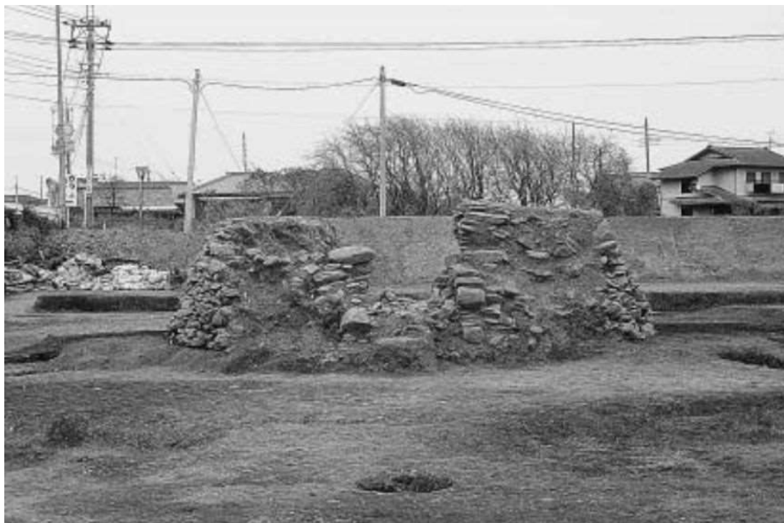
石室遺存状況 1（正面、南から）
