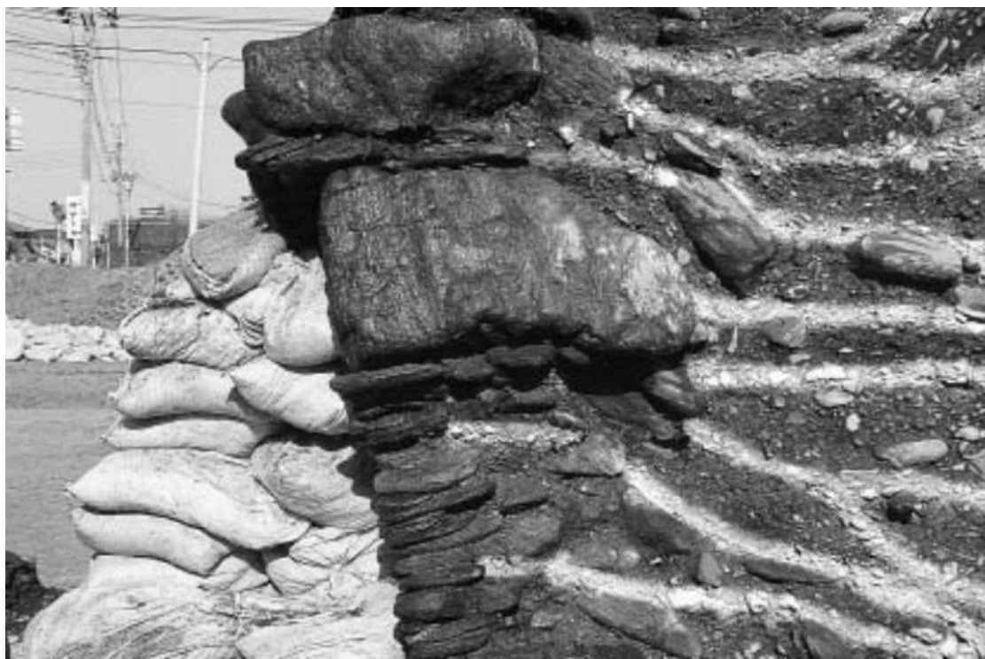
控積断ち割り状況 3 (東側・部分)
