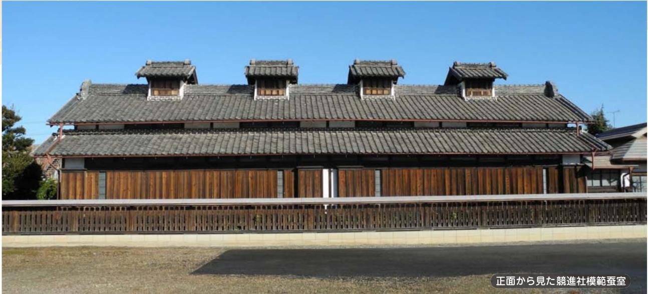
競進社模範蚕室は養蚕を伝習するための専用の蚕室で、外観は一見して平屋に見えるが、中二階建て下屋付きの和風建造物である。屋根の上に高窓（越屋根・ヤグラ）が4つ乗るのが大きな外見的な特徴となっている。
