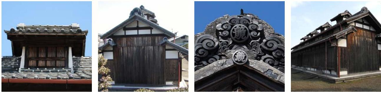
模範蚕室を側面から見ると左右が対称に見える形をしている。建物の南側と北側に下屋をだし、その内部は廊下となっている。主屋根と下屋の屋根の間が狭いが、ここに明かり取りの欄間が設けられている。北側の廊下は南側より幅が狭いので、下屋の屋根も少し小型となっている。
