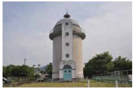
写真 2-13 児玉町旧配水塔
