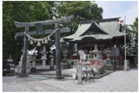
写真 2-3 八幡神社社殿及び銅製鳥居
