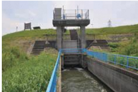
写真 9-6 備前渠用水路（第3樋門）
