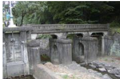
写真 9-9 間瀬堰堤管理橋
