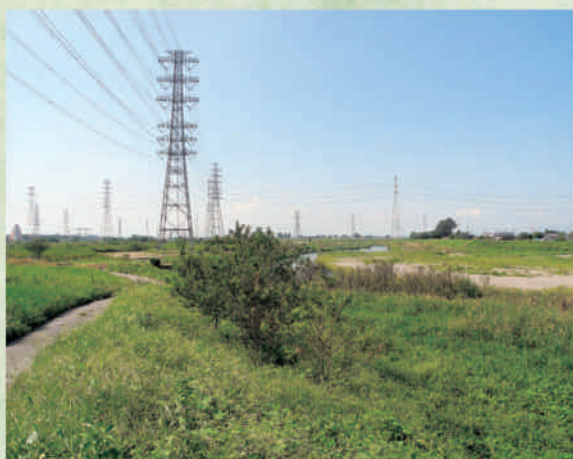
堀田地内 小山川渡河地点
