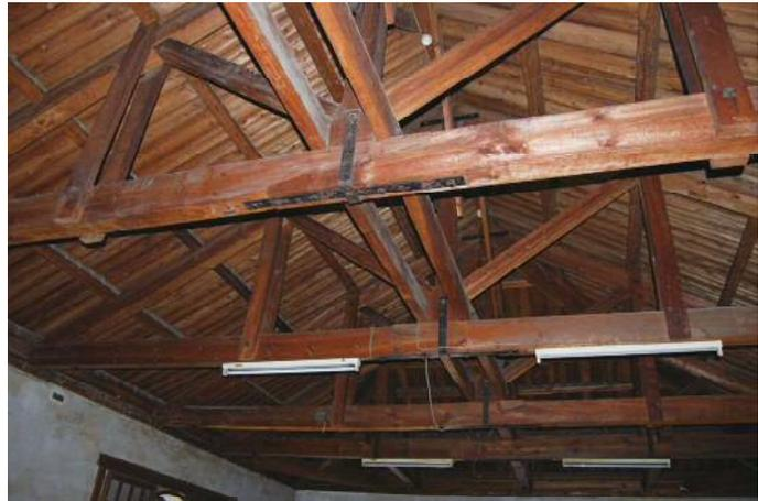
中右、二階の小屋組み 木製トラス構造
