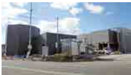
建設中の「アスピアこだま」
